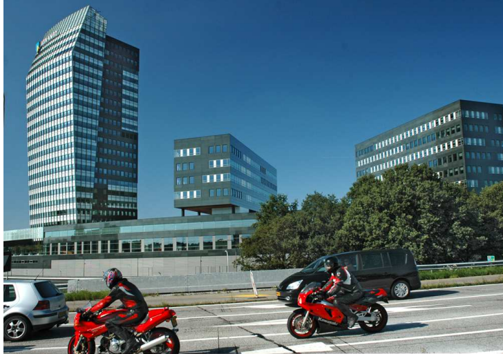
Kantoorlocatie Voorsterpoort aan de A28.
