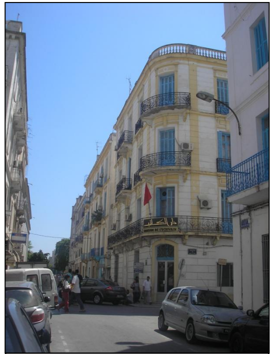
Afb. 7 Verpauperde flats in La Nouvelle Ville.
