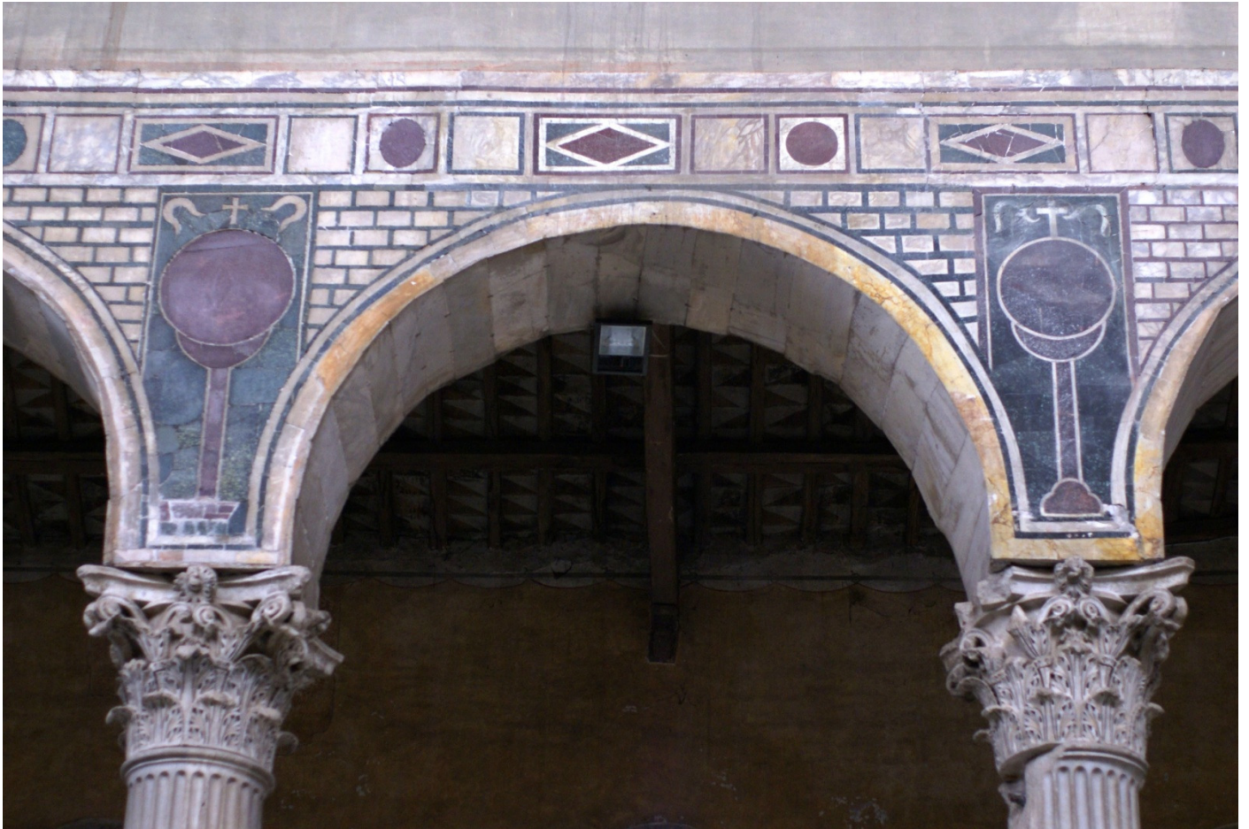
Afb. 25. vijfde-eeuws opus sectilebekleding van de arcade van de Sant Sabina. (Auteur, zomer 2005.)
