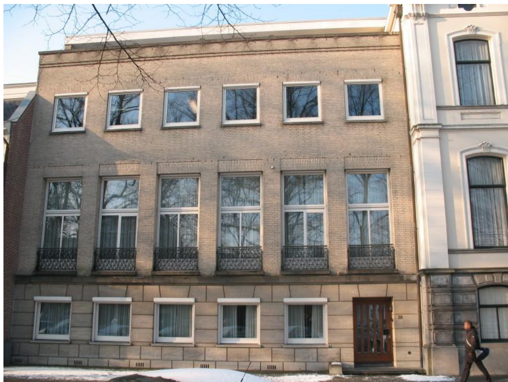
Afbeelding 6.31 Maliebaan 38 (gebouwd 1963, foto 2010) Nieuwbouw op Maliebaan 38 ten behoeve van het aangrenzende aartsbisschoppelijk paleis. Het nieuwe gebouw heeft zes traveeën, twee meer dan het oude pand en de ingang is verplaatst naar de rechterzijde. Het heeft ook een extra bouwlaag.
