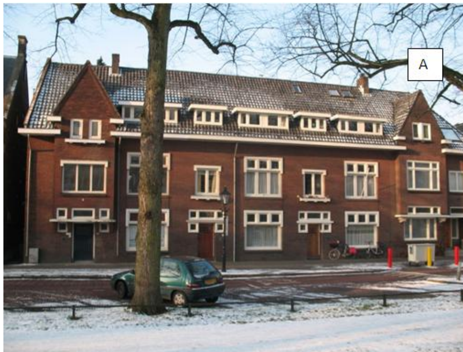
Afbeelding 6.38 Maliebaan 52-54A (gebouwd 1932, foto 2010) Deze vier huizen staan op de locatie van bovenstaand herenhuis. Het vierde – laatst aangebouwde huis - staat rechts (A). De kleur van de baksteen van dit huis wijkt iets af van de andere.
