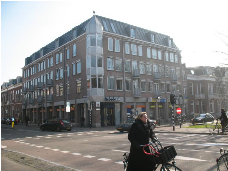
Afbeelding 6.7 Maliebaan 53 (gebouwd 1984, foto 2011) Op de locatie van de kerk, hoek Maliebaan/Burgemeester Reigerstraat, werd een groot complex met dienstverlenende bedrijven op de begane grond en appartementen op de etages daarboven gebouwd.
