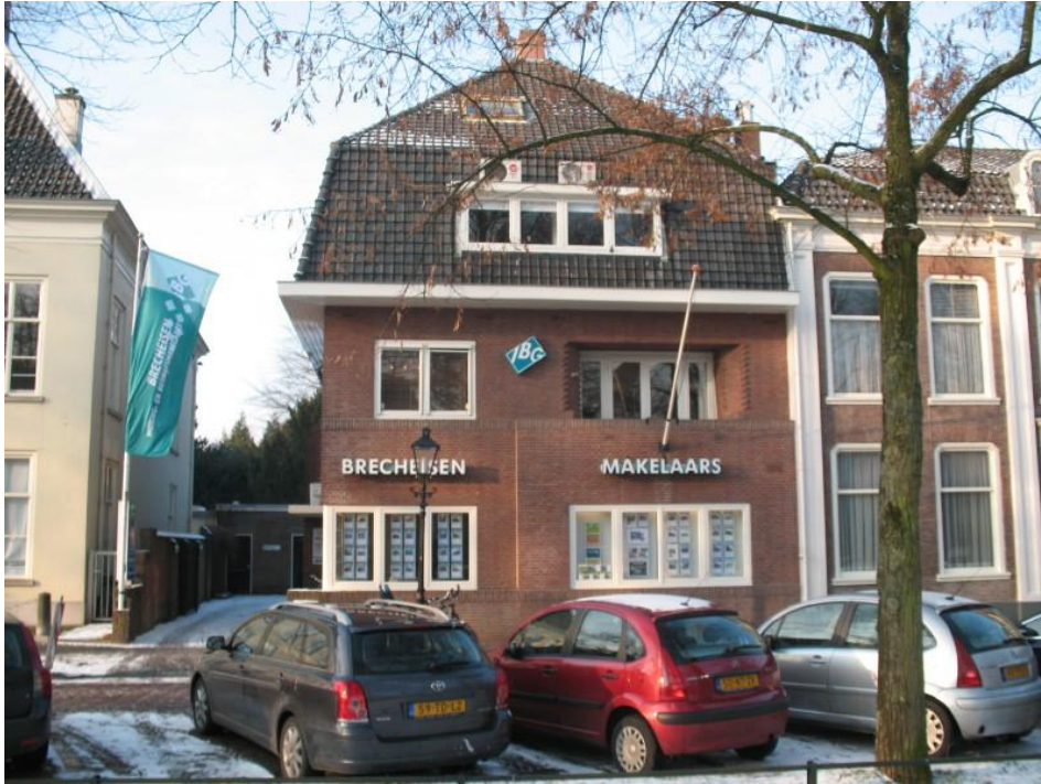
Afbeelding 6.15 Maliebaan 2 (gebouwd vóór 1946, foto 2010)
