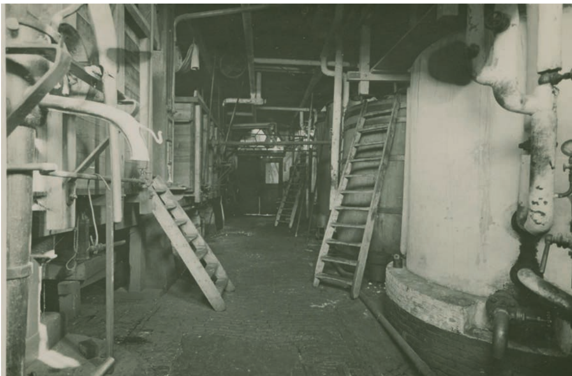
^ Afbeelding 14: interieur van een branderij met aan de linkerkant beslagbakken en rechts distilleerketels. Onbekend, geen jaartal. Uit beeldbank gemeentearchief Schiedam, inventarisnummer 01896.
