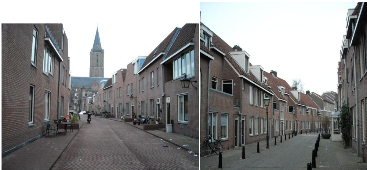
Nieuwbouw in de Jan Meijenstraat met op de achtergrond de Jacobikerk (links) en de nieuwbouw in de Oranjestraat (rechts).
