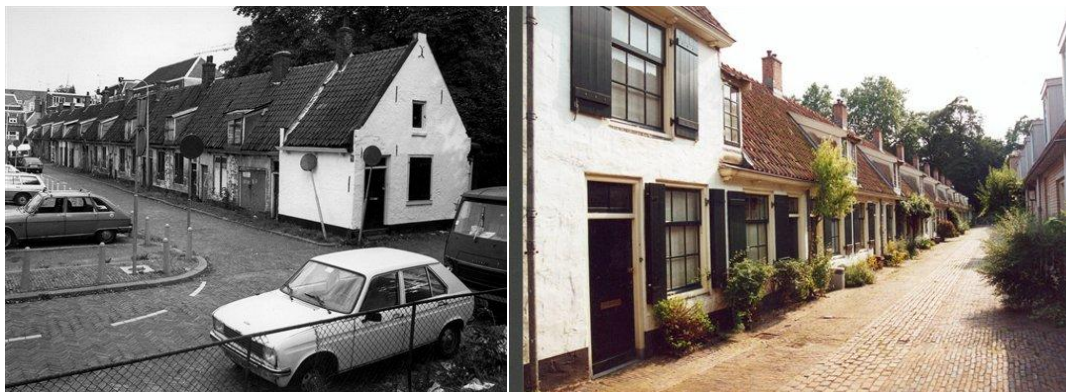
De Tuinstraat in het Springhavergebied voor (links) en na (rechts) restauratie en nieuwbouw.
