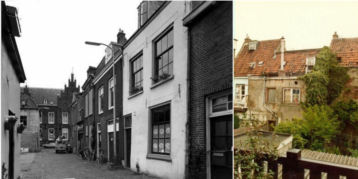
De Andreasstraat met (links) de nummers 10 en lager en het Andreasklooster en (rechts) de achtergevels van de nummers 6 tot en met 10.
