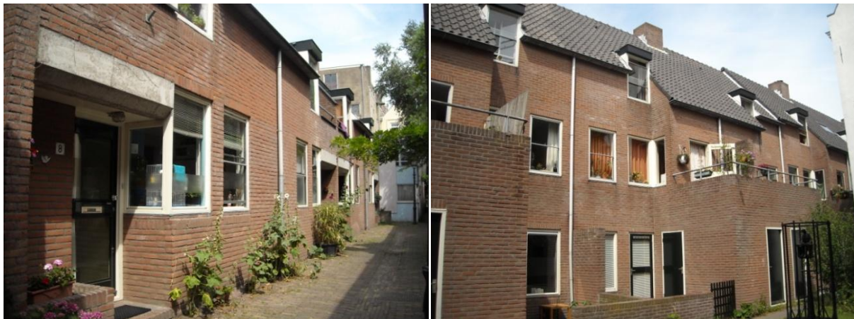
De nieuwe woningbouw aan de Zwaansteeg is gebouwd volgens de zogenaamde aannemersdoorsnede .
