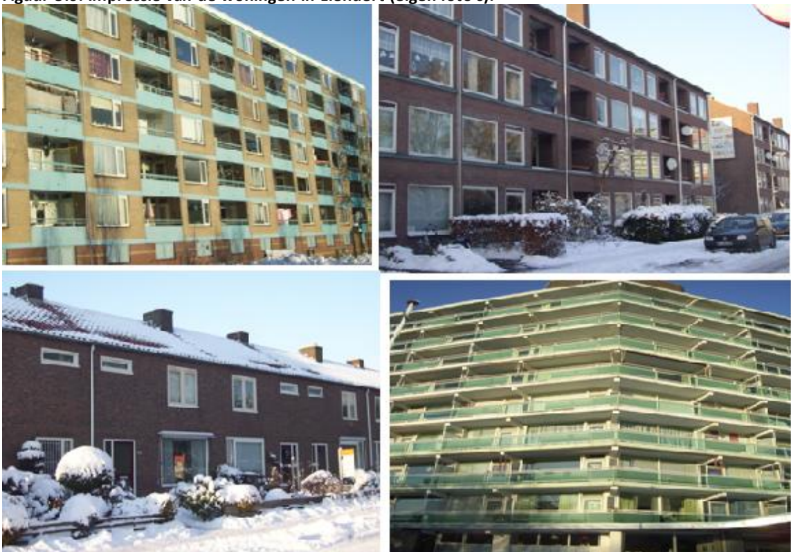
Figuur 5.6: Impressie van de woningen in Liendert (eigen foto's):
