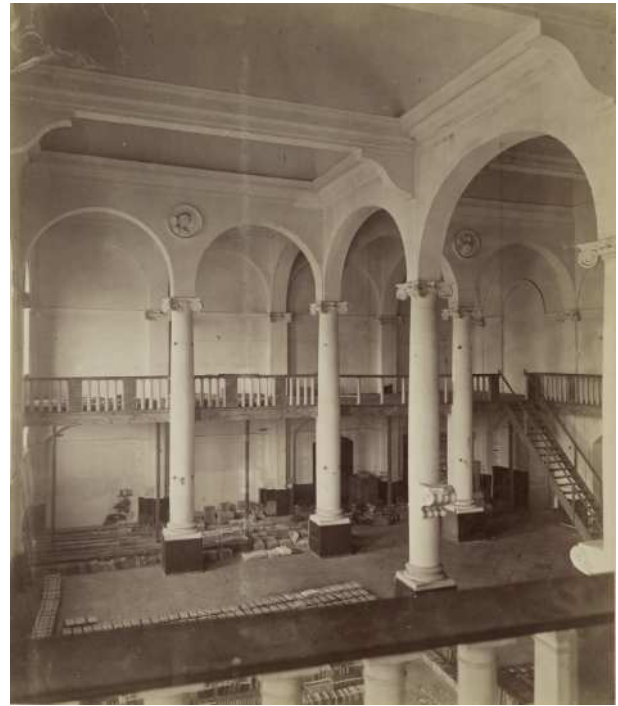
De Hofkapel van het Binnenhof, vlak voor de afbraak en de bouw van de nieuwe, door Nieuwenhuis ontworpen gebouwen, 1879. [RCE, Amersfoort / OF-03634]
