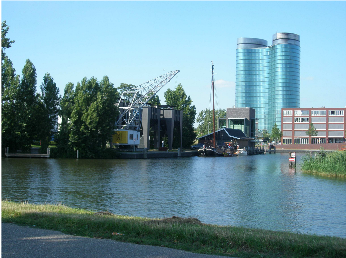
Afbeelding 10. De oude Veilinghaven aan het Merwedekanaal. Geheel rechts nieuwbouw, in het midden het nieuwe kantoor van de Rabobank en links omgebouwde zandtrechters die in gebruik zijn als vergaderruimtes.
