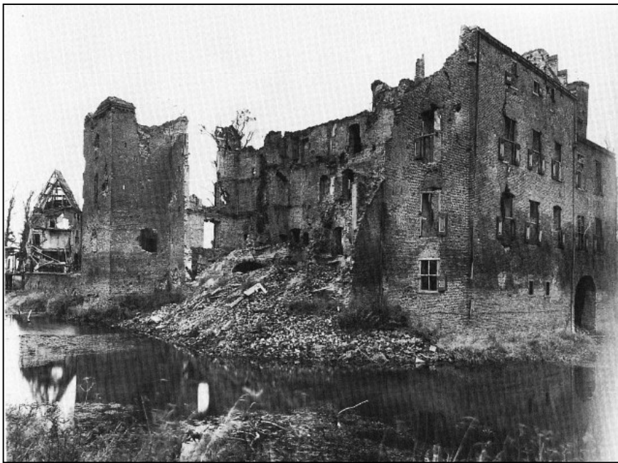
(afb. 14) Het zwaar beschadigde kasteel Doorwerth, 1946.
