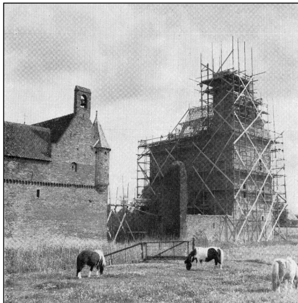
(afb. 38) Kasteel Doornenburg tijdens de restauratie in 1958.
