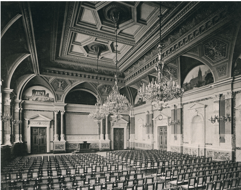
Abb. 89: Aula im Hauptgebäude der Königlich Technischen Hochschule zu Berlin.
