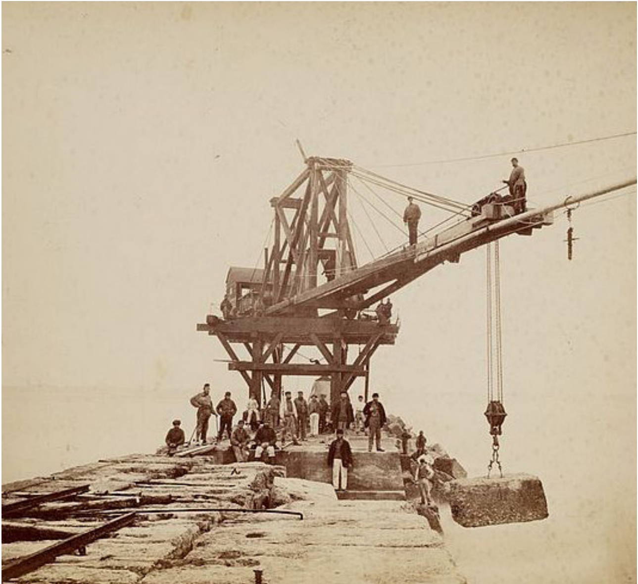
Afbeelding 32: Herstel aan Zuidpier na storm, nog tijdens de bouw (1871-72)
