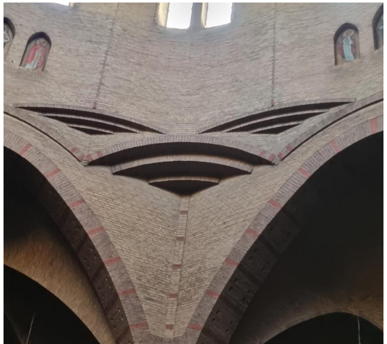
Afb. 39. Detail van de gemetselde bogen die de zeskant in een twaalfkant doen overgaan. Ook de knikken in de koepeltrommel zijn te zien.
