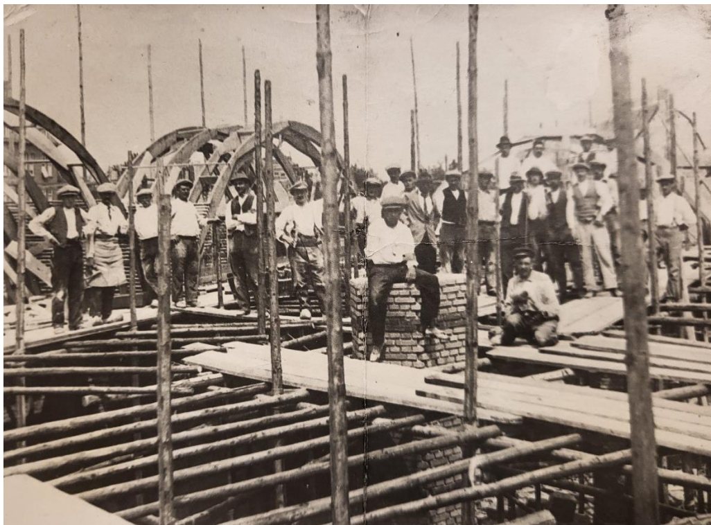
Afb. 38. Bouwlieden poseren op een steiger, 1923. Een persoon zit op een van de zes middenpijlers. Op de achtergrond zijn formelen gesteld.
