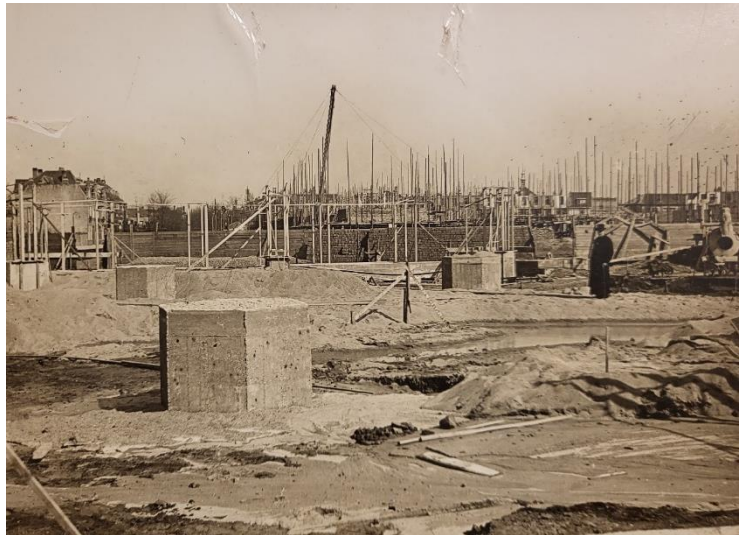
Afb. 32. De werken zijn begonnen: de basementen van de pijlers worden gestort, 1923.
