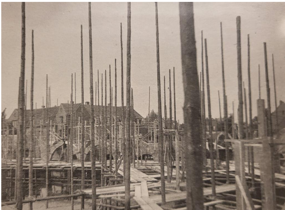
Afb. 37. De steigers worden steeds hoger en de eerste bogen worden gesloten, 1923.
