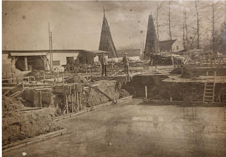
Afb. 33. Het storten van beton, 1923.
