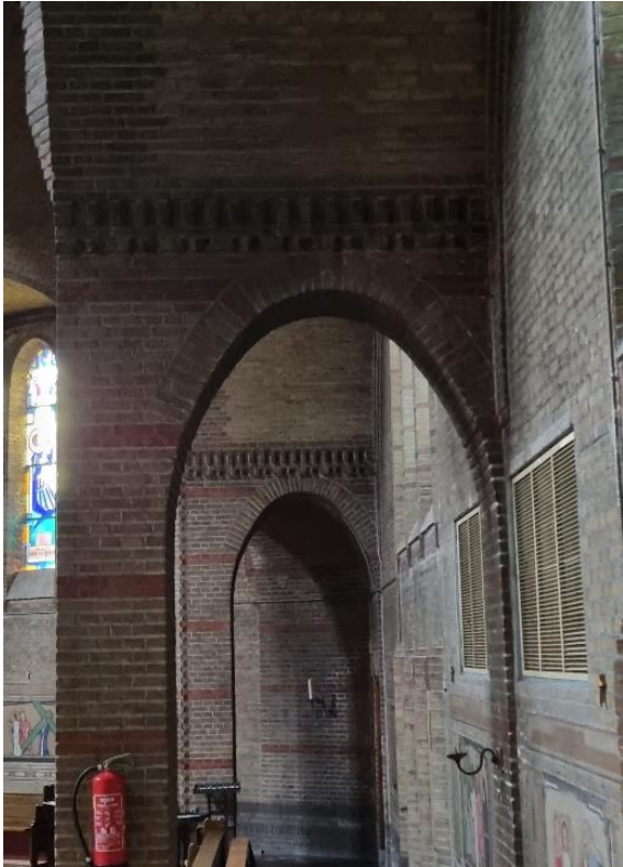
Afb. 11. De buitenste omgang, voorzien van paraboolbogen en overwelfd met rondbogen (of smalle tongewelven)
