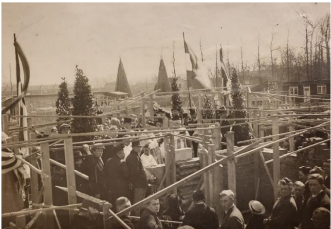
Afb. 34, 35 & 36. Foto's van de eerste steenlegging, 5 april 1923.
