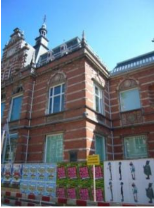
Afb. 13. De twee originele roeden bij de entree
