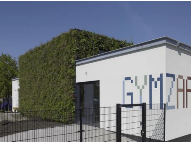
Living Wall Utrecht (Kanaleneiland): UMP-LW
