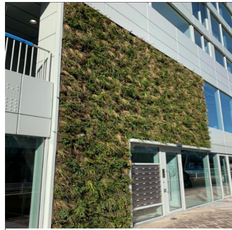
Living Wall Utrecht (Centre) UHP-LW
