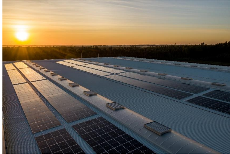
Figuur 4: Zonnepanelen op een dak
