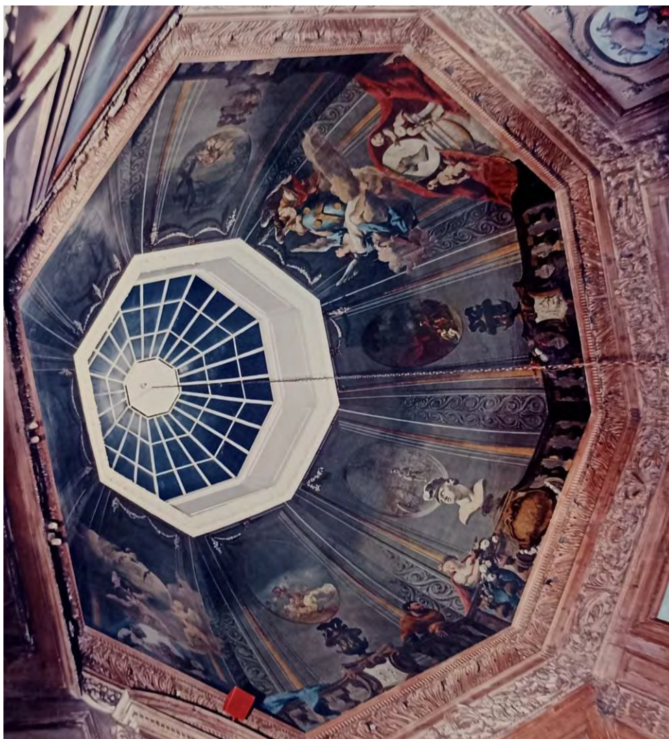
Afb. 58 Zicht op de koepel van Hopetoun House na restauratie, 1984 (Foto: collectie Historic Environment Scotland).
