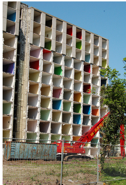
Figuur 7.1: Sloopwerkzaamheden in Utrecht Overvecht.
