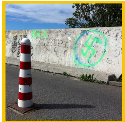
Figuur 9: Hakenkruis op brug over A12 (De Gelderlander, 2014)
