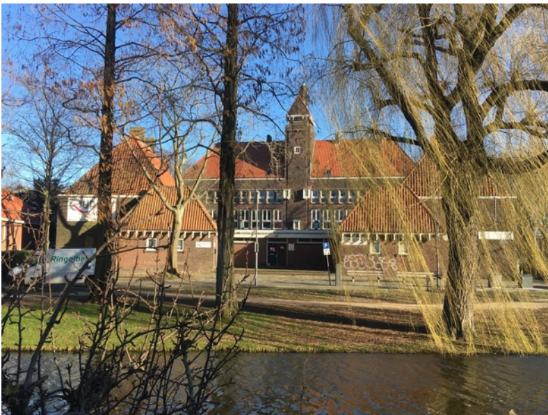
Afb. 4.3. Zegenstraat 120 gezien vanaf de overzijde van de Boergoensevliet.
