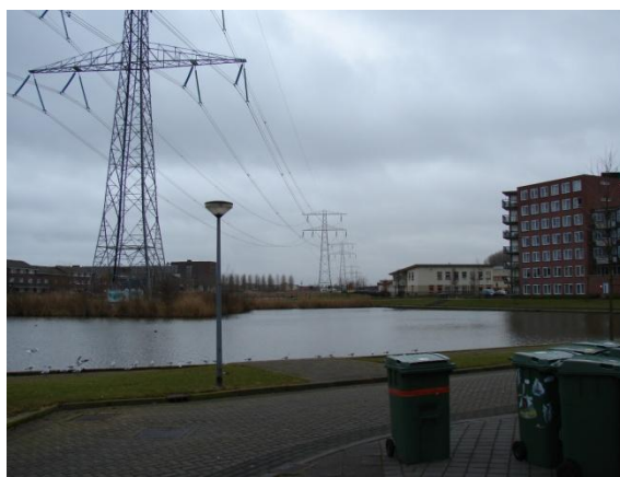
Figuur 6. De bestaande 380 kV-verbinding tussen de woningen in Almere Stad
