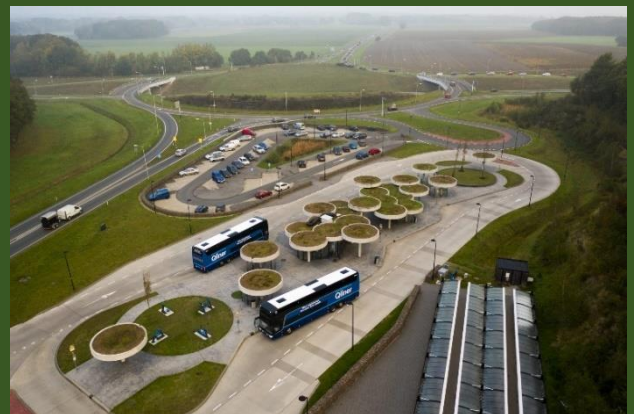
Figuur 6.3: Hub P+R Gieten met overdekte fietsenstalling, kiosk en kluisjes waar men kan overstappen op streekbussen en Qliners (Reis via hub, 2023)
