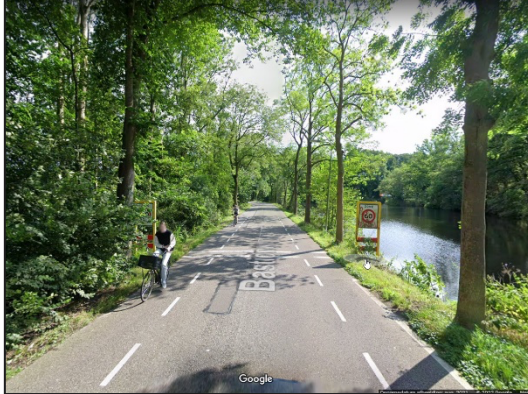
Afbeelding 27: Bastionweg met een fietsuggestiestrook, 60 km/h maximumsnelheid en geen voetpad ernaast (Google Maps, 2021)
