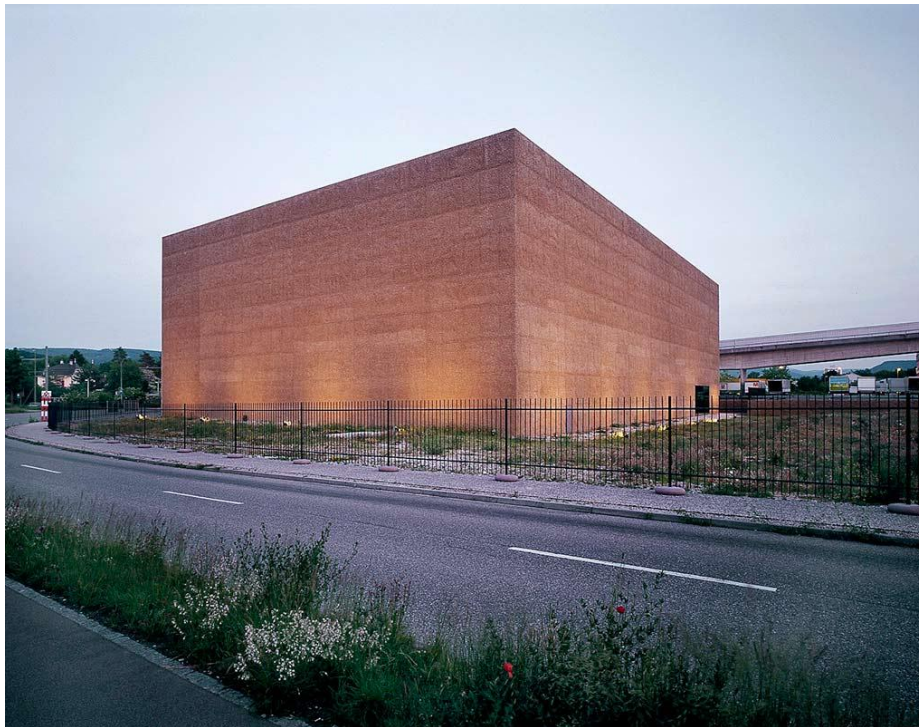
Gevel Schaulager, Basel.
