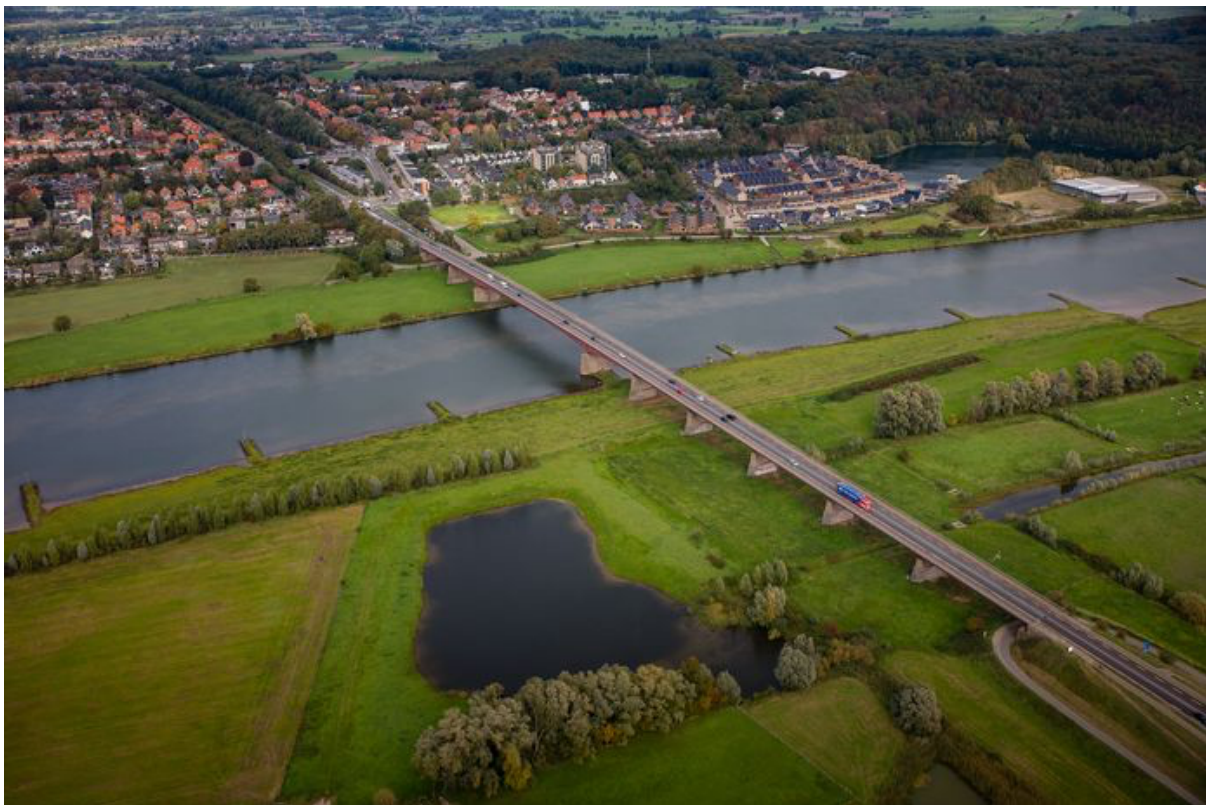
Afbeelding 1: Zicht op de Rijnbrug als onderdeel van de N233 met op de achtergrond Rhenen (Wijnacker, 2020).
