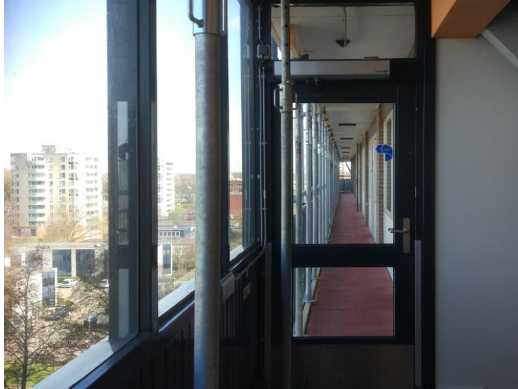
Figuur 4 Een ondersteunde galerij van de flats
