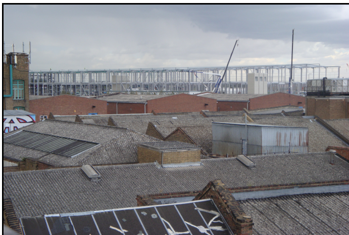
Figuur 8.4: International Broadcast Centre in aanbouw
