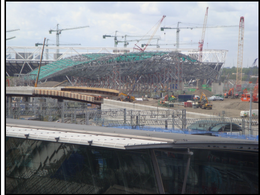
Figuur 8.3: Aquatic Centre in aanbouw
