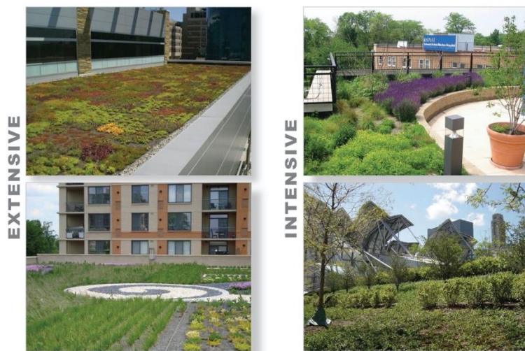
Figuur 3.3: Afbeeldingen van intensieve en extensieve groendaken (Bron: RAMCON Roofing, 2011)
