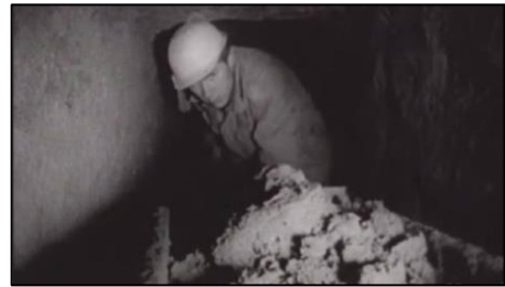
Leonardo Fedeltà tijdens het graven van de tunnel
