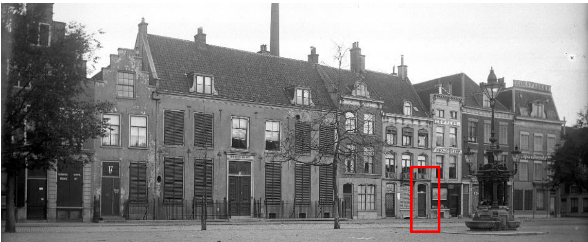
Rijksmunt met aangrenzende panden. Rood: smalle doorgang naar het binnenterrein. Bron: U.A. nr. 64605
