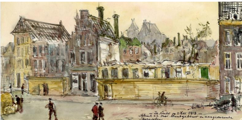
Afbraak complex in 1918. Zijkapel en patershuis gesloopt. Voormalige kapel staat nog Bron: U.A. nr. 39466
