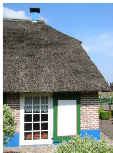
Afbeelding 3. Een roedeverdeling in een deuropening die uit functioneel oogpunt nooit een roedeverdeling gehad heeft.
