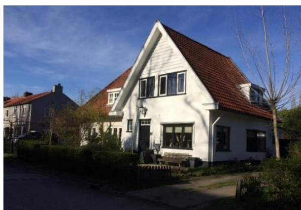
Afbeelding 6: Woning voor de chef der werkplaatsen, gerealiseerd in 1931.
