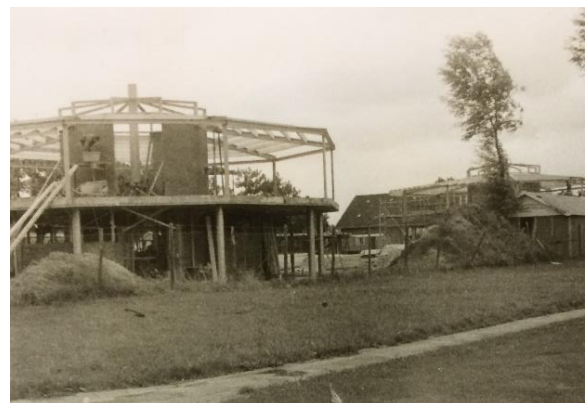
Afbeelding 19: Bouwfoto (datering onbekend) constructie paviljoen.
