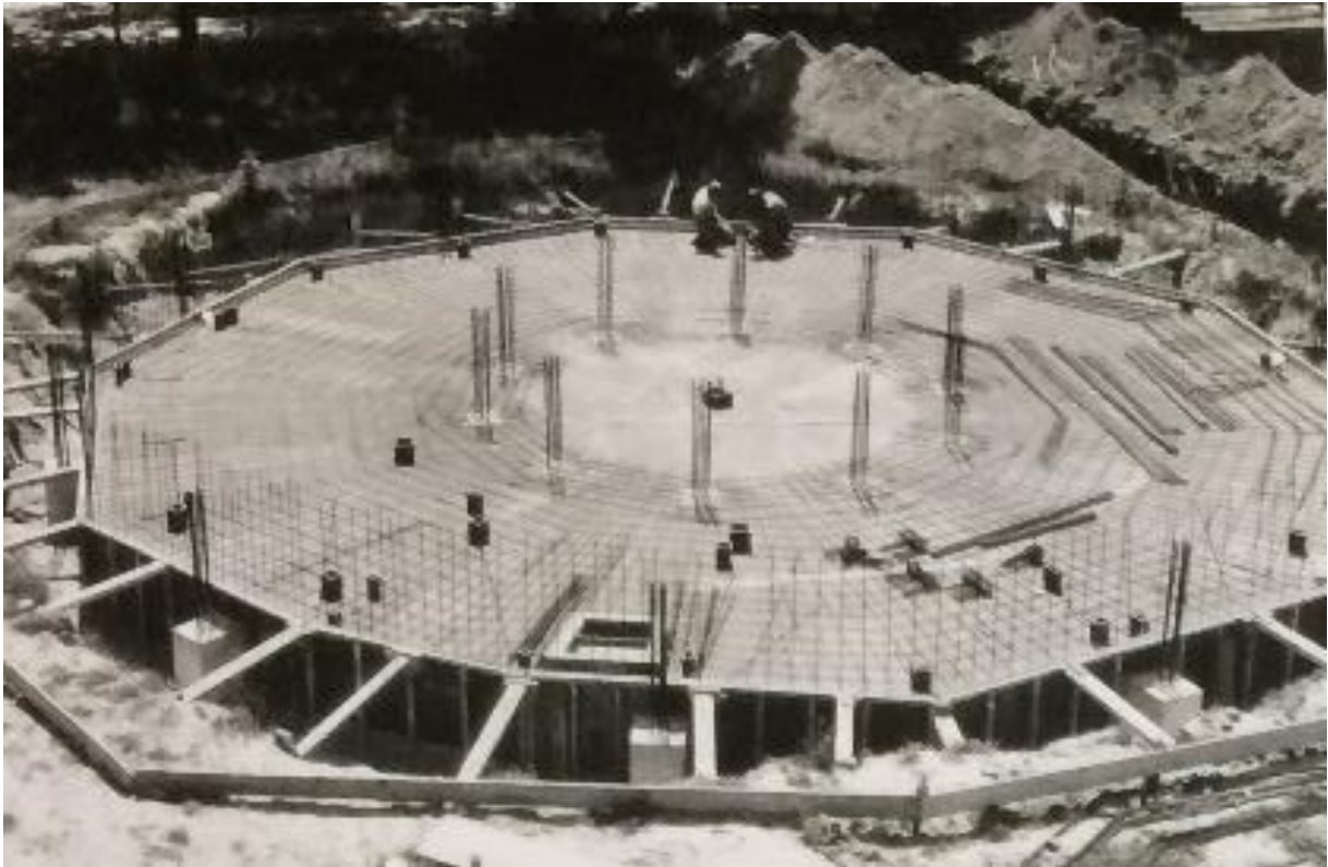
Afbeelding 115: Begane grond vloer met wapening voor twintig kolommen.
