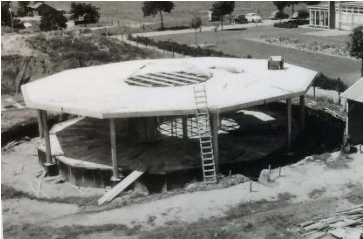
Afbeelding 118: Constructie eerste bouwlaag.
