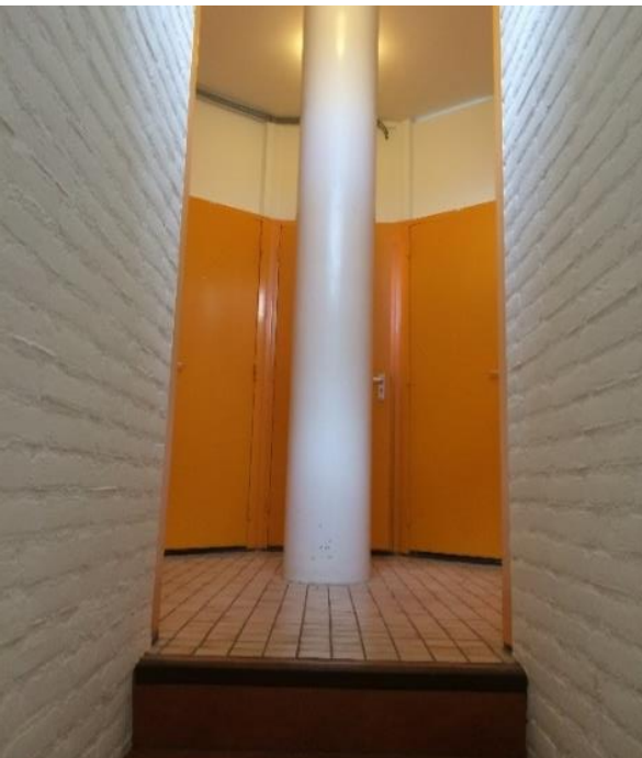
Afbeelding 135: Openhaardbuis met daaromheen sanitaire voorzieningen en bergingsruimte.
