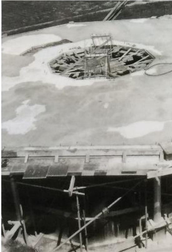
Afbeelding 117: Gestorte eerste verdiepingvloer.
