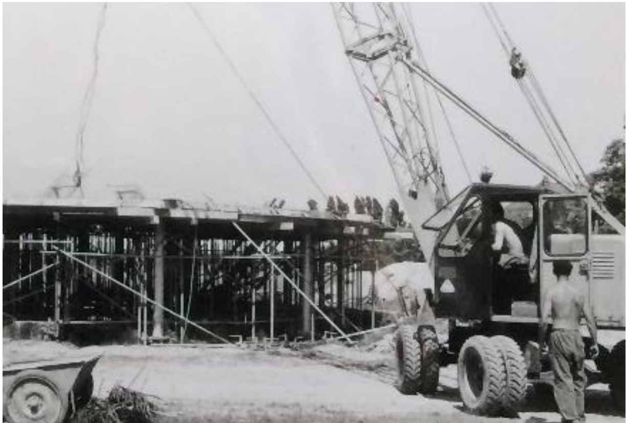
Afbeelding 116: Eerste verdiepingsvloer met bekisting en stutten.
