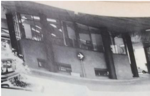
Afbeelding 64: Begane grond ingangsrondte met kolommen tegen de buitengevel aan.
