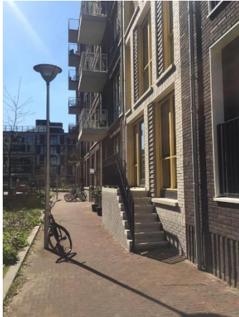
Figuur 5.4: Voordeuren buitenkant
