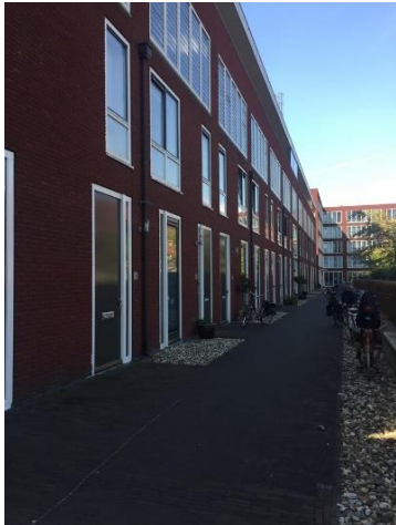
Figuur 5.22: Voordeuren binnenkant
