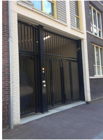
Figuur 5.5: Parkeergarage buitenkant
