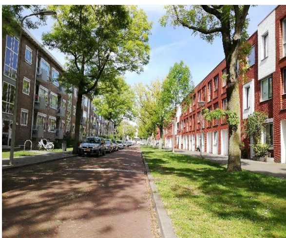
Figuur 3.4 Menging van eigendomstype woningen (links: sociale huur, rechts: koop en vrije sector) in de Vledderstraat, Morgenstond-West (eigen foto)
