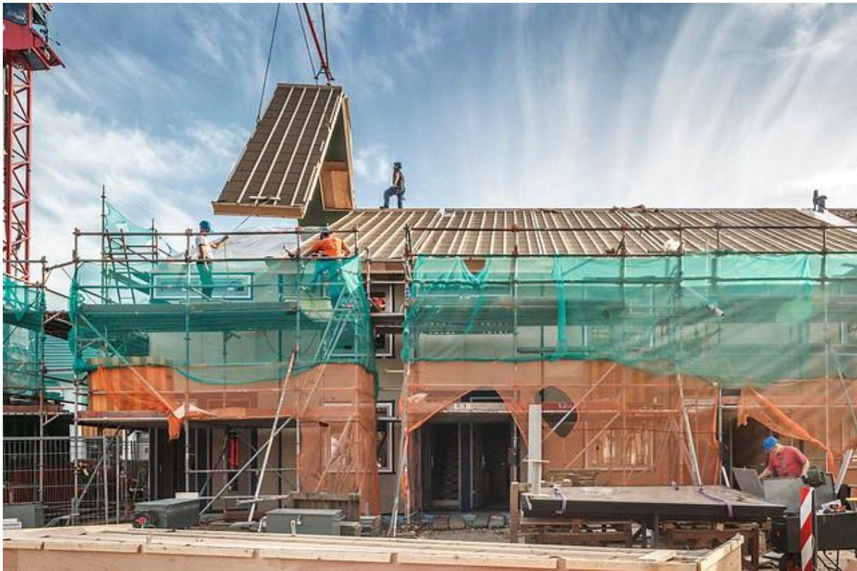
Figuur 22: Installatie van een dakelement (Beeldenbank BAM, 2018)
