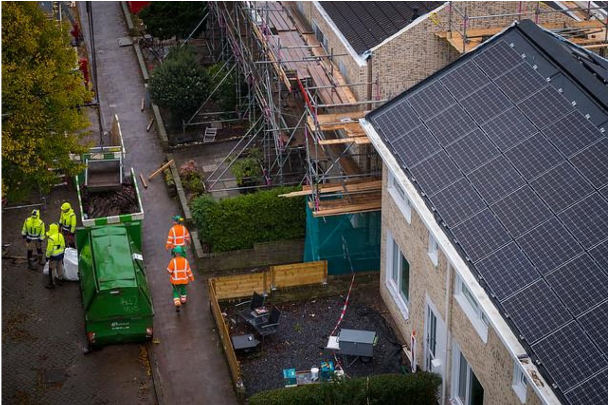
Figuur 12: De bouwplaats (Beeldenbank BAM, 2018)
