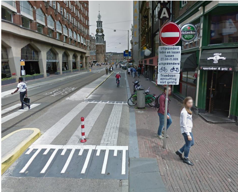
Afbeelding 6.1 en 6.2: Situatie na de herinrichting van het Muntplein: stuk minder autoverkeer
