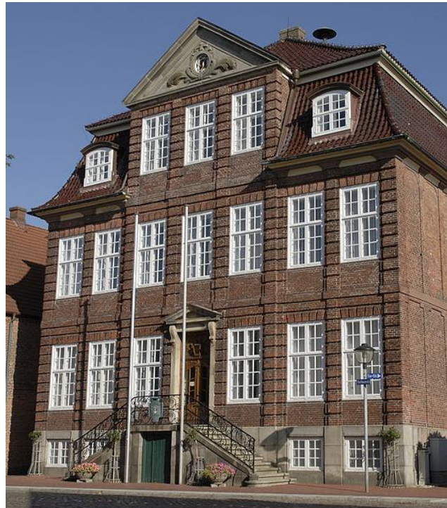
Afb. 16 Het raadhuis in Wilster met de gereconstrueerde voorgevel uit 1938, 2006. Foto: T. Bolten (Wikimedia Commons).
