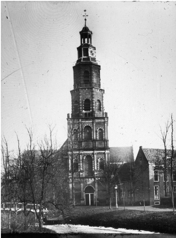
Afb. 44 De St. Nicolaaskerk in IJsselstein voor de restauratie, z.j. Foto: onbekend (Rijksdienst voor het Cultureel Erfgoed).
