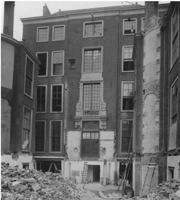
Afb. 58 De achtergevel van het huis 'Groen van Prinsterer' tijdens de restauratie, vlak na de sloop van de jongere aanbouwen, 1943. Foto: E.M. van Ojen (Haags Gemeentearchief).
