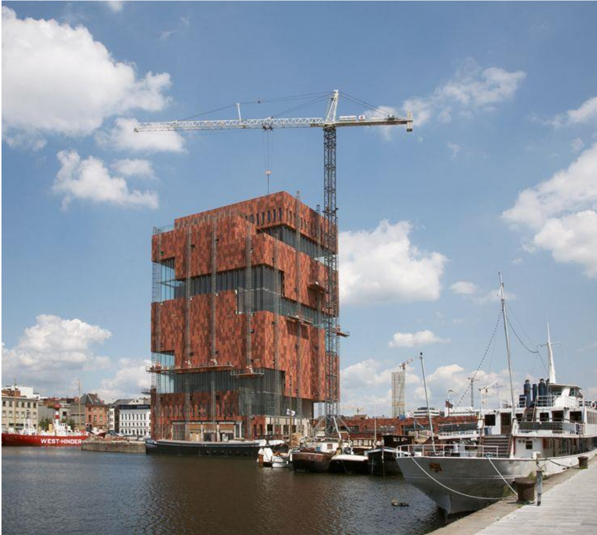
Afb. 12 Het Museum aan de Stroom in Antwerpen in de steigers. Foto: Museum aan de Stroom < http://www.mas.be/Museum_MAS_NL/MASNL/Over-het-MAS/Ontstaan.html > (laatst gezien op 14 mei 2015) © Bart Huysmans.
