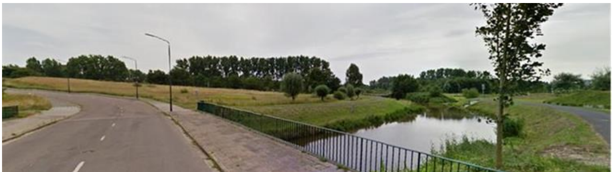
Figuur 93: De Oranjebrug over de De Aa of Weerijis, toegangsweg tot het wijkdeel van Schaaap.
