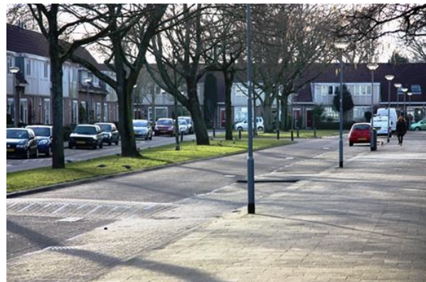
Figuur 27: Variatie in straatprofielen. Hier een steeds breder wordende straat met middenberm. Frankendaal.
