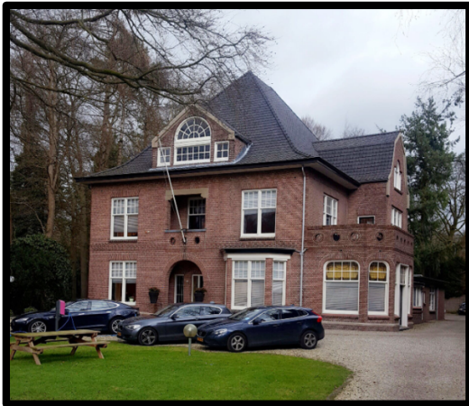
7.7. Bijlage 7 – Tesla's voor de deur van kantoor (Kirkman Company)
