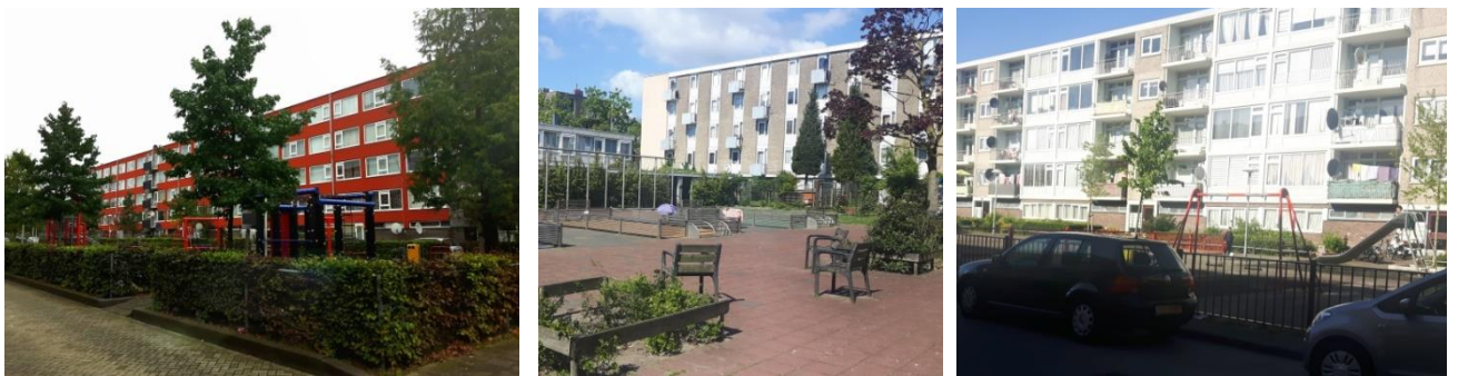
Figuur 5.5: Voorbeelden speelplekken op de binnenplaatsen in Kanaleneiland
