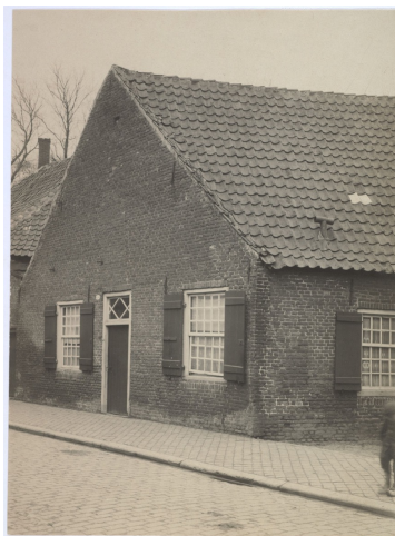
77-79. Links boven: situatie 1880; BHC hulpkaart M3287. Links onder: situatie uit 1900; BHC M5619. Rechts: weverswoning in 1914; RAT 027222.
