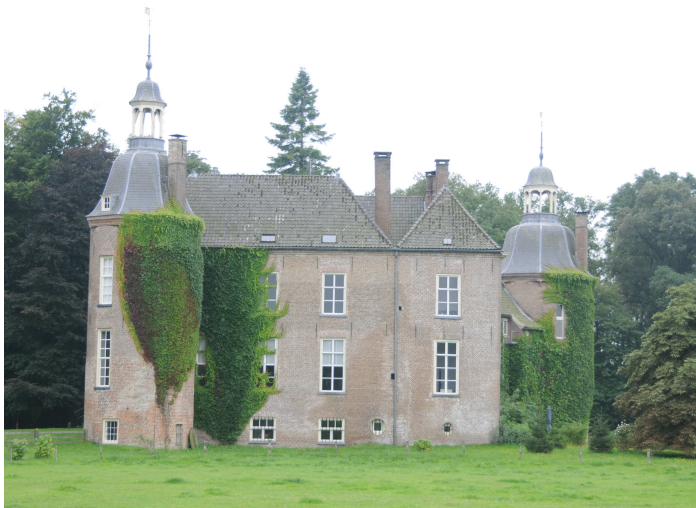
AFBEELDING 3.4. Het kasteel Hackfort, situatie 2008.
