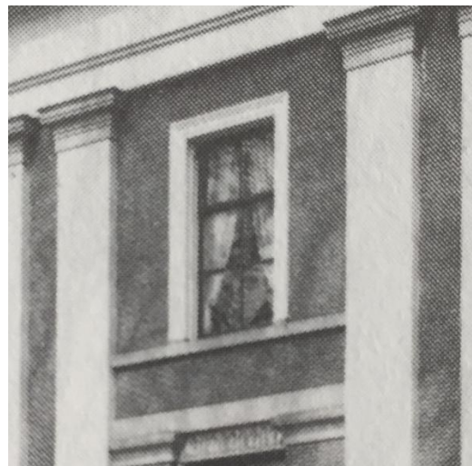
Afb. 41a. Detail vensternis.
