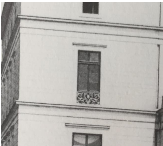
Afb 39a. Detail vensternis.
