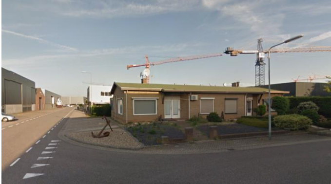
Figuur 30. Bedrijfshallen- en woningen op de Industrieweg
