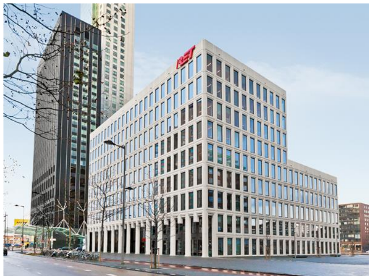
Figuur 14 Bedrijfsgebouw RET in Rotterdam Bron: Hannover Leasing, 2016.
