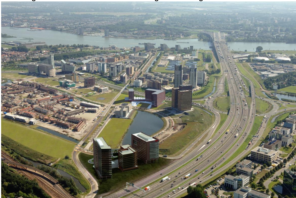
Afbeelding 7: Voorbeeld van een zichtlocatie langs een snelweg
