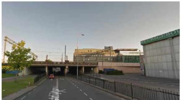
4. Onderdoorgang spoor en Beursgebouw, noordzijde, is door haar lengte en vormgeving onaantrekkelijk voor voetgangers.
