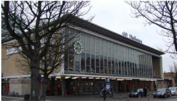
1. Stationsgebouw, rijksmonument, wordt op dit moment aangepast en uitgebreid met behoud van cultuurhistorie.
