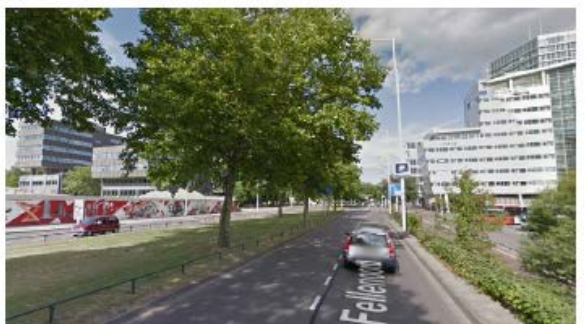
8. Fellenoord, met links het Rabobankterrein, waar een nieuw gebouw wordt gerealiseerd. Er mist nog een logische overstek richting station.
