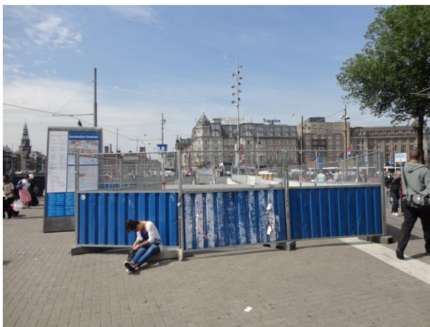
Figuur 5.12: Werkzaamheden op het stationsplein (Luna, 22, Duitsland)
