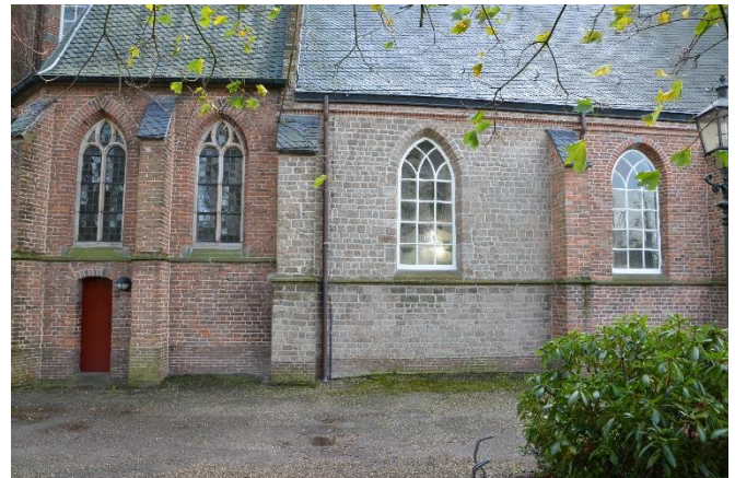
Afbeelding 36. De tufstenen muur, Andrieskerk Amerongen.
