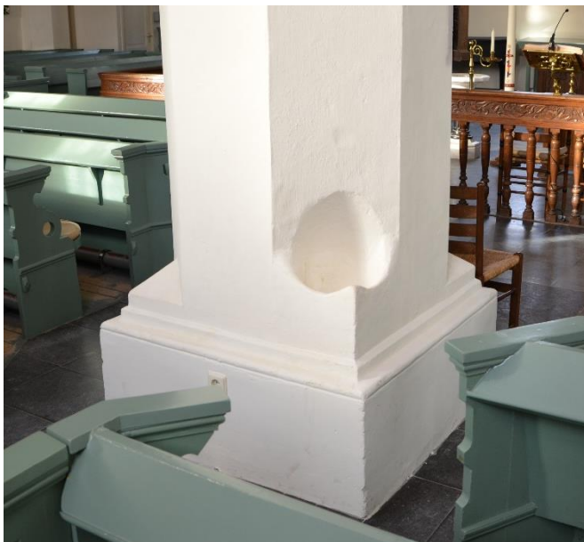
Afbeelding 9. De wijwaterbak uitgehouwen in de pilaar, ca. 1480, Andrieskerk Amerongen. Het bevindt zich ter hoogte van de derde en vierde travee, gerekend vanaf de toren, in de zuidelijke beuk.
