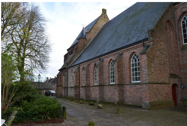
Afbeelding 35. De noordelijke buitenmuur, Andrieskerk Amerongen. De twaalfde-eeuwse tufstenen (lichter en grijzer van kleur) is duidelijk te zien.
